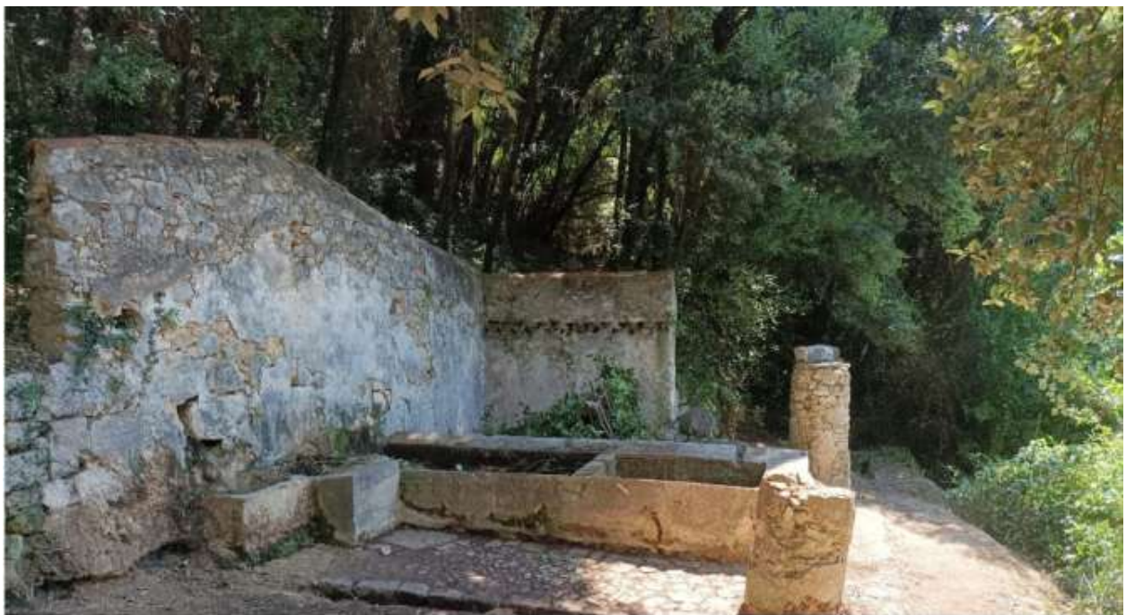
Après première tranche de travaux (2024)
