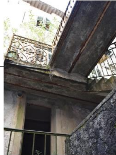
Structure des escaliers
