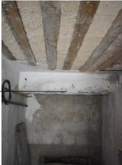
Structure des planchers
