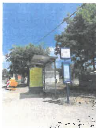
sur l'abribus au croisement de la RD 5 et de la Route des Grottes
